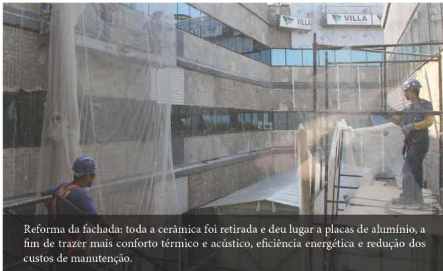
Reforma da fachada: toda a cerâmica foi retirada e deu lugar a placas de alumínio, a fim de trazer mais conforto térmico e acústico, eficiência energética e redução dos custos de manutenção.
