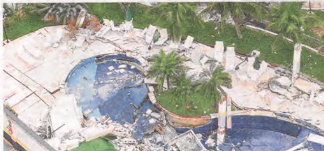
Área de lazer do condomínio na Enseada do Suá desabou em julho de 2016
