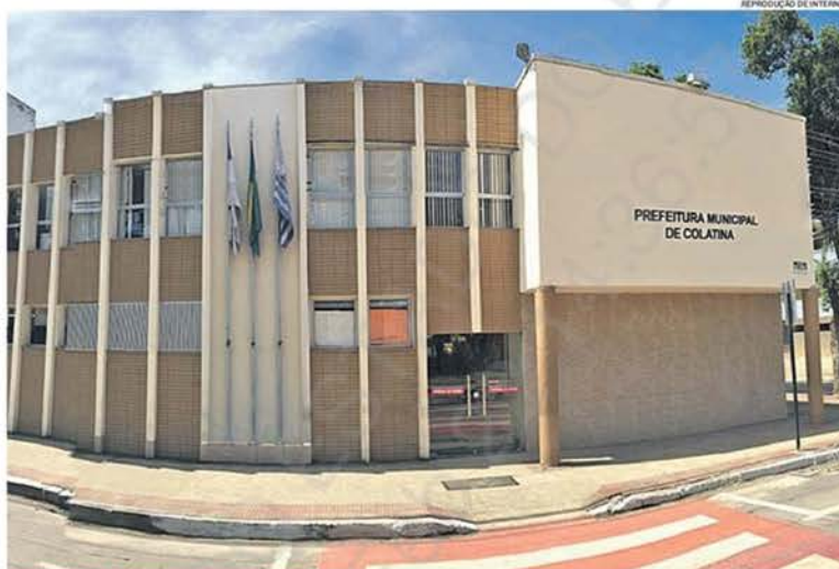
FACHADA DA PREFEITURA DE COLATINA: 75 cozinheiros serão selecionados em regime de designação temporária
