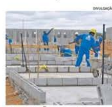
CONSTRUÇÃO de moradias
