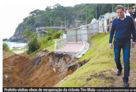
Prefeito visitou obras de recuperação da ciclovia Tim Maia | DIVULGAÇÃO/PREFEITURA DO RIO
