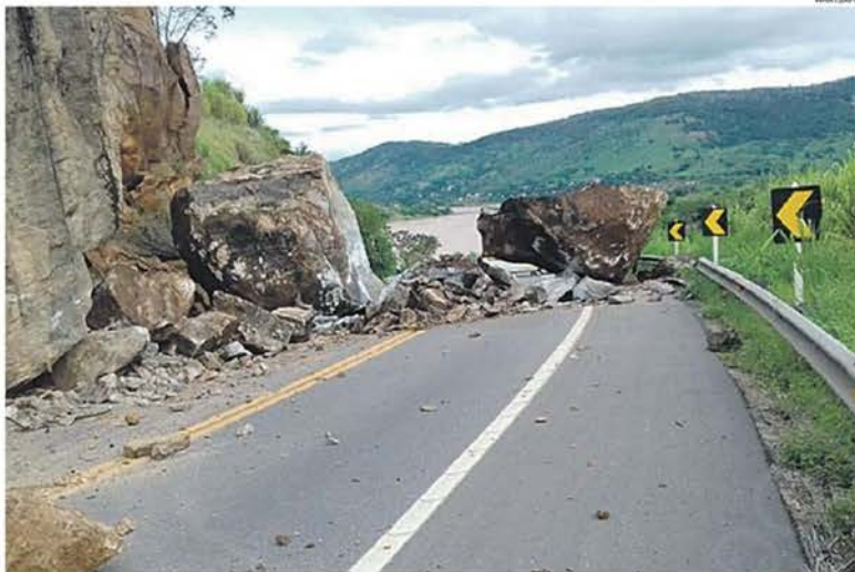
BR-259, EM ITAPINA, distrito de Colatina: as pedras rolaram no dia 6 de fevereiro, interditando totalmente a pista
