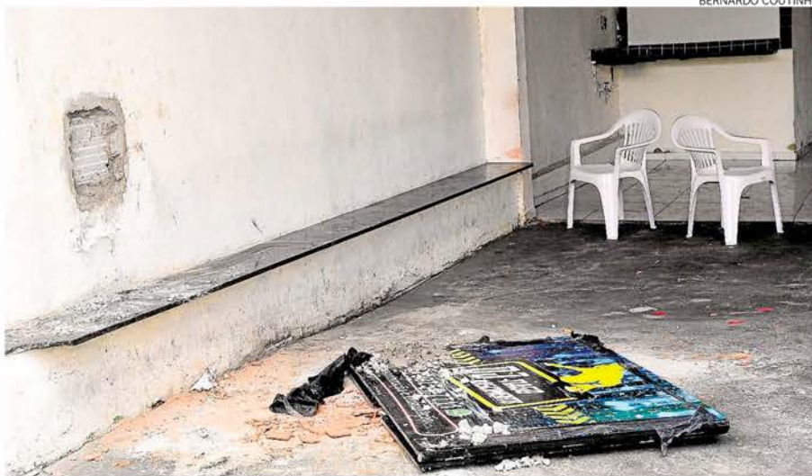
Buraco na parede do cerimonial usado pelos criminosos para furtar armas de dentro do fórum foi fechado
