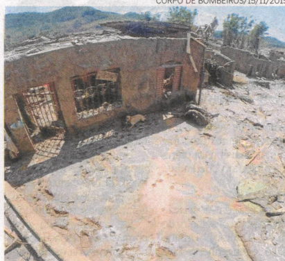
Bento Rodrigues, em Mariana, ficou destruído
