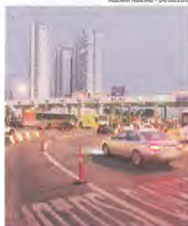
TERCEIRA PONTE: concessão
