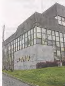
Edifício-sede da Prefeitura de Vitória
