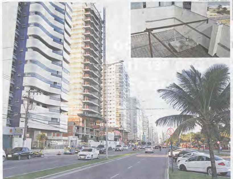
PRAIA de Itaparica: obra no terraço de um edifício (destaque) é motivo de conflito entre vizinhos do mesmo prédio
