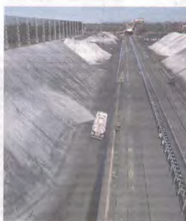
AREA INDUSTRIAL DA VALE: fiscalização do Iema
