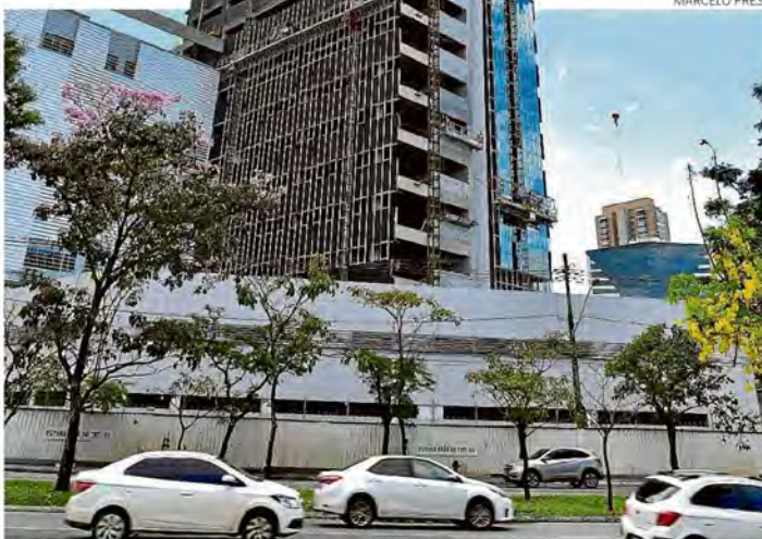
Prédio do TRT, em construção, deve ficar subutilizado quando estiver pronto
