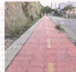
RUA Dep. Otaviano: rachaduras
