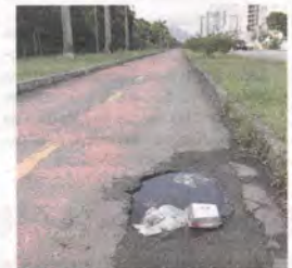
BURACO em faixa da Norte-Sul
