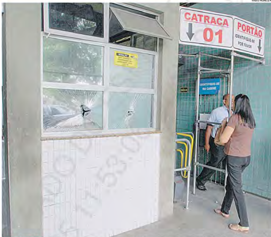
VIDROS FORAM destruídos logo na entrada do Terminal de Laranjeiras, na Serra, durante paralisação
