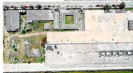
Imagem aérea mostra obra abandonada do Cais
