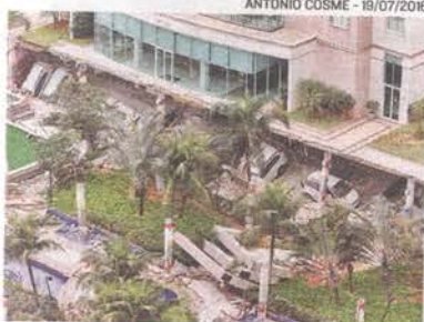
DESTROÇOS após desabamento
