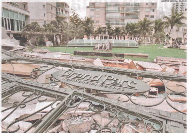
ÁREA de lazer do Grand Parc, que desabou ano passado: cálculos estruturais foram subdimensionados, diz laudo
