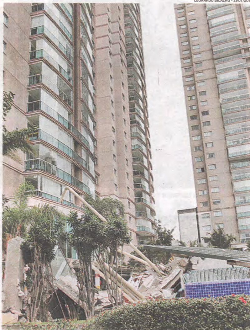
TORRES DO GRAND PARC: laudos apontam irregularidades nas estruturas
