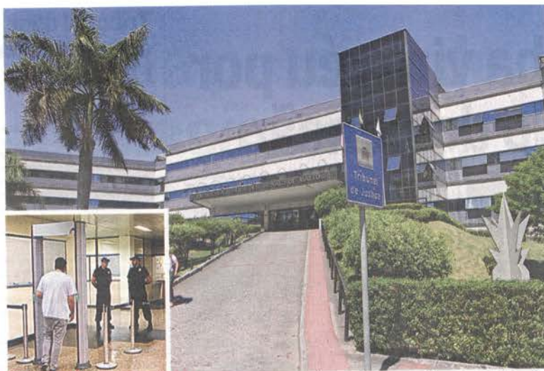
FACHADA DO TRIBUNAL DE JUSTIÇA, onde detector de metais (destaque) já está instalado na recepção do prédio
