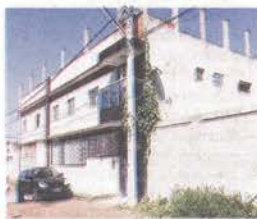
POSTE usado para acessar varanda
