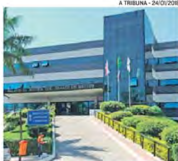
FACHADA DO TJ: substituição
