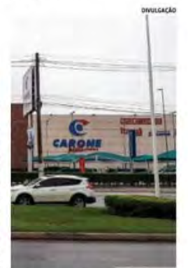
Construtora alega inadimplência
