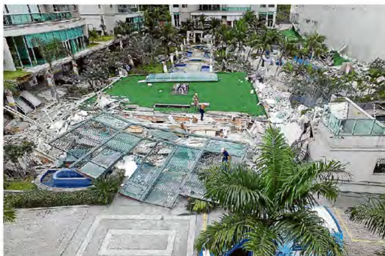
Desabamento da área de lazer do Grand Parc, em 2016: engenheiros responsáveis pela obra respondem a processo
