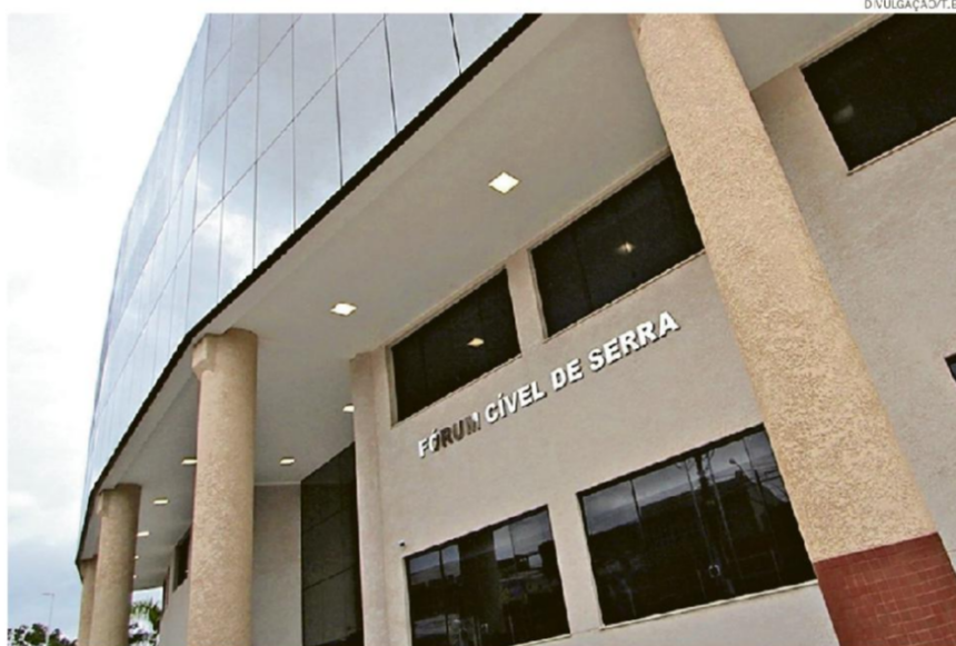
Fórum Cível da Serra é abrigado em um imóvel alugado, em Carapina, desde dezembro de 2017
