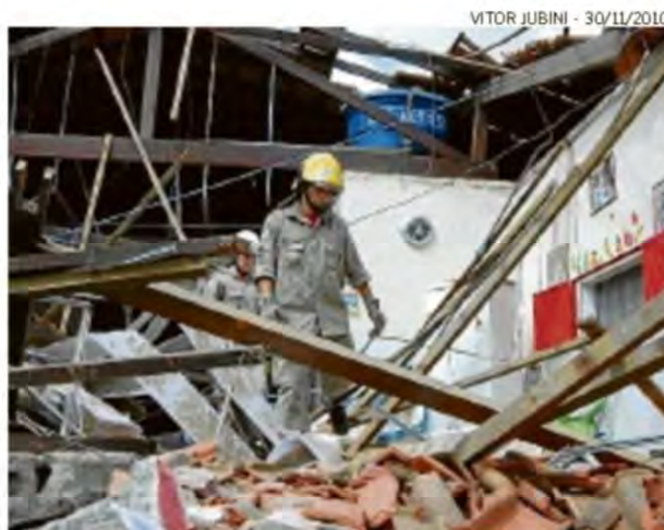
Telhado de creche desabou em novembro de 2010
