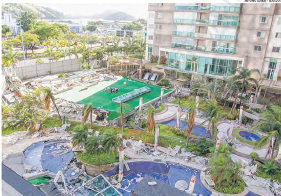
COM O DESABAMENTO da área de lazer do prédio, moradores de 166 apartamentos tiveram de deixar suas casas
