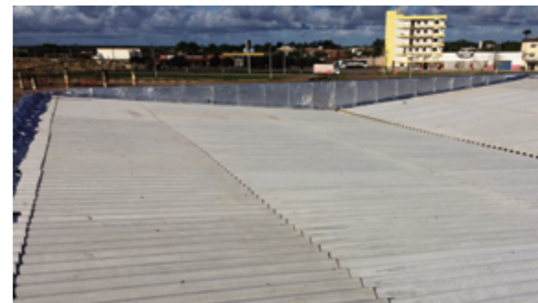
Novo telhado do Fórum de Pedro Canário
