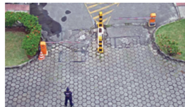
As cancelas instaladas na área de estacionamento do Tribunal de Justiça auxiliam no controle de acesso
