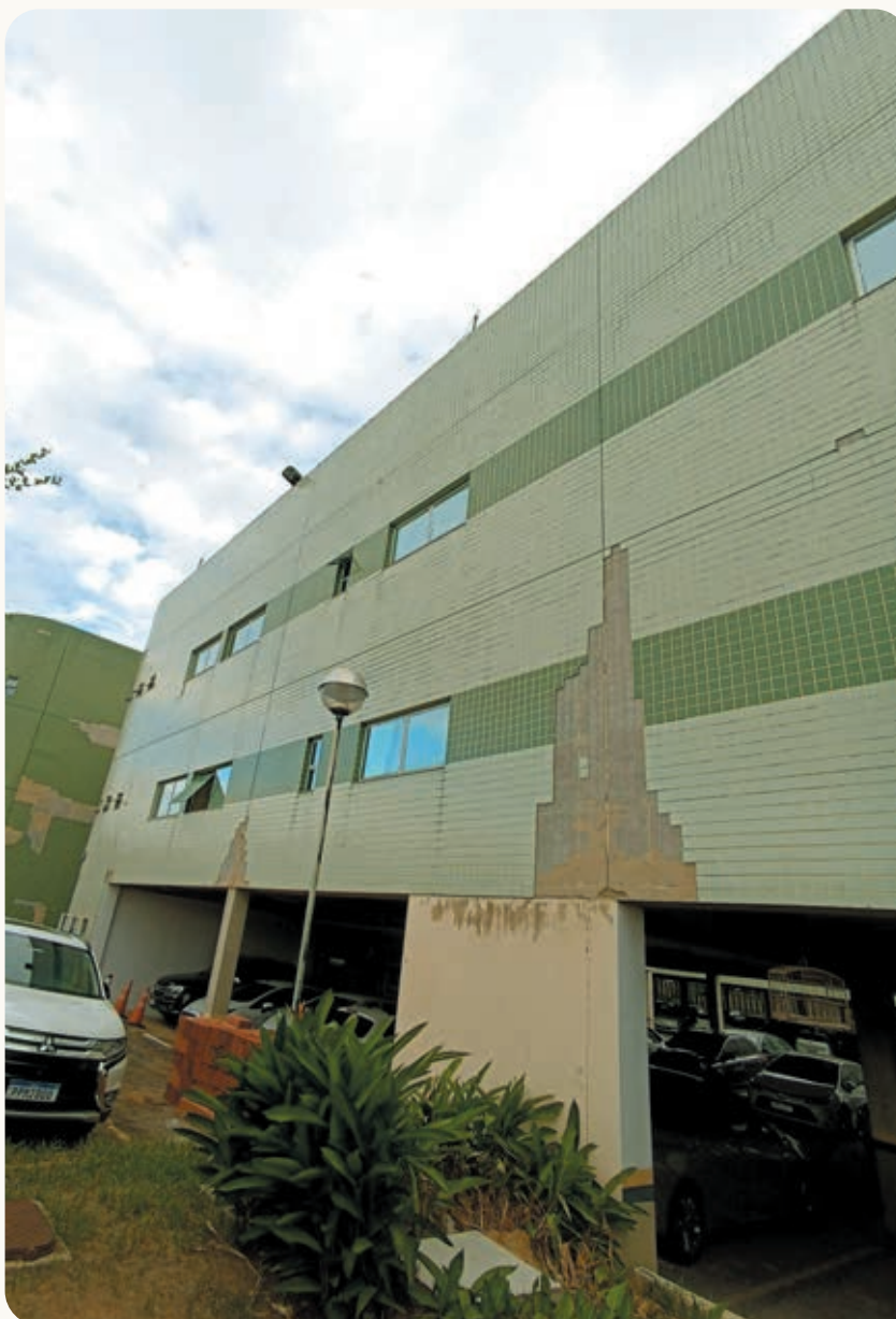
Manutenção na fachada do Fórum de Colatina devido ao deslocamento de cerâmica – Em andamento.
